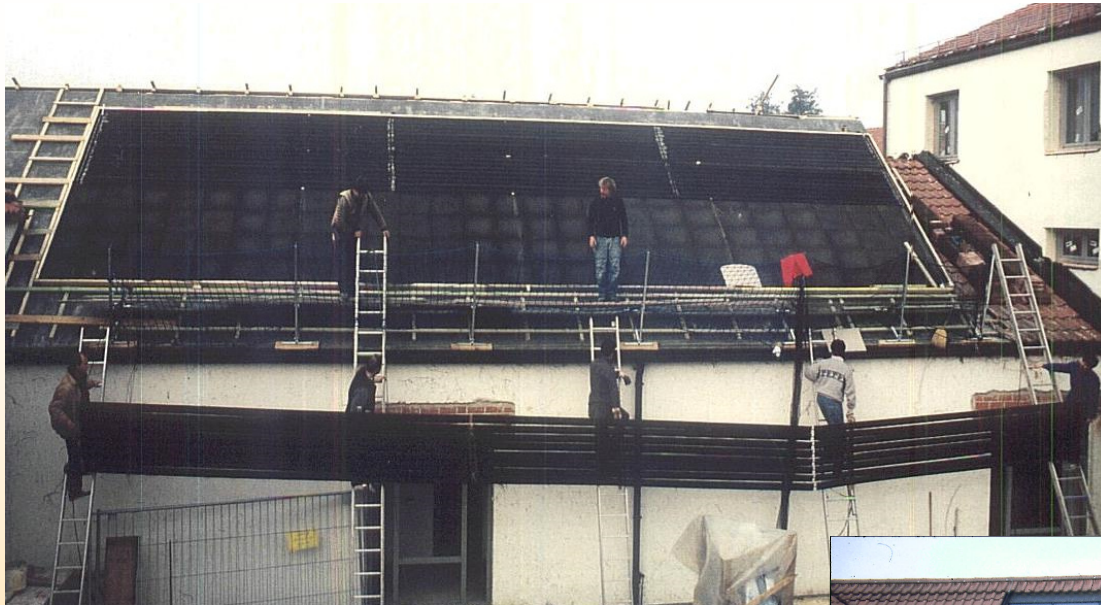
Auf dem Dach der LVHS in Niederaltich montieren wir gemeinsam 60 m 2 Kollektoren
